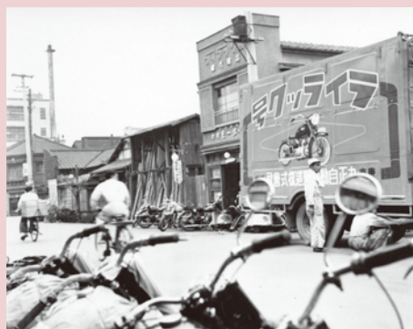
六間道路沿にあった丸正自動車製造本社
